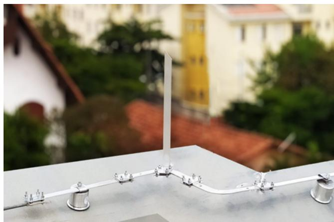
Figura 7 - Captação com minicaptadores, barras chatas, aderibase e conectores multigrampo. Fonte: Autor/2020
