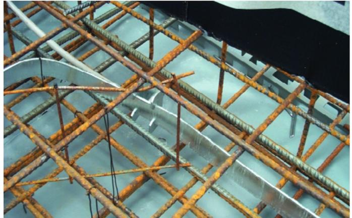
Figura 13 - Utilização de barras chatas de aço e rebar no aterramento estrutural.
